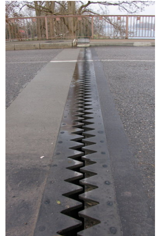
Joint de dilatation thermique d'un pont
